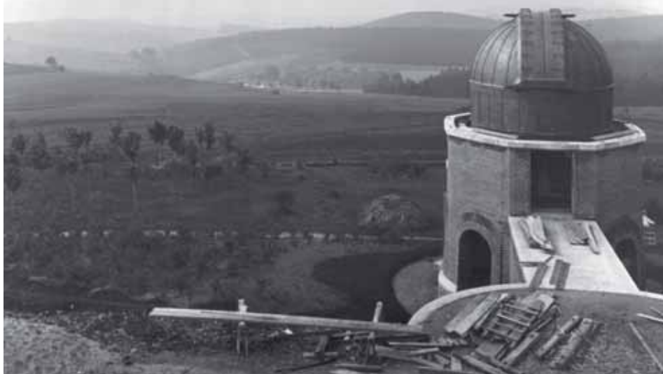
Západní kopule ve výstavbě
